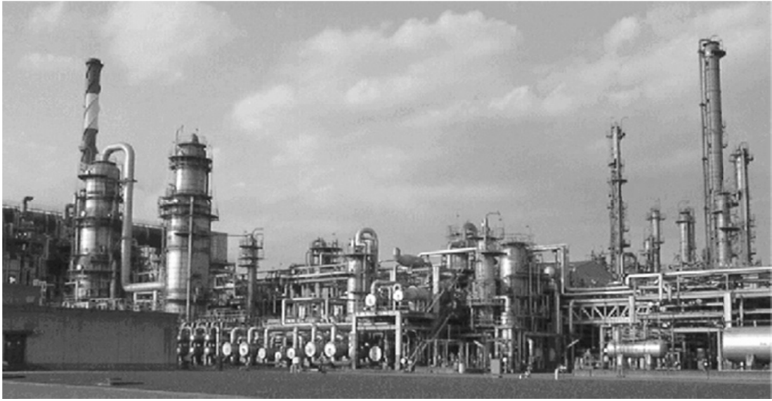
図 5.1 エチレンプラント
