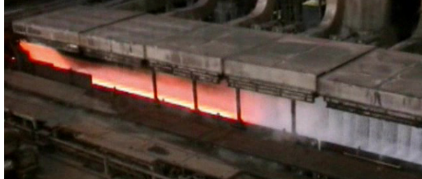
図 3 ランアウトテーブル冷却設備
