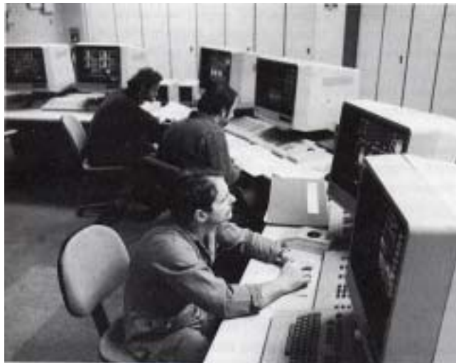
図 1.2 コンピュータ化されたプロセス制御室 [12]
