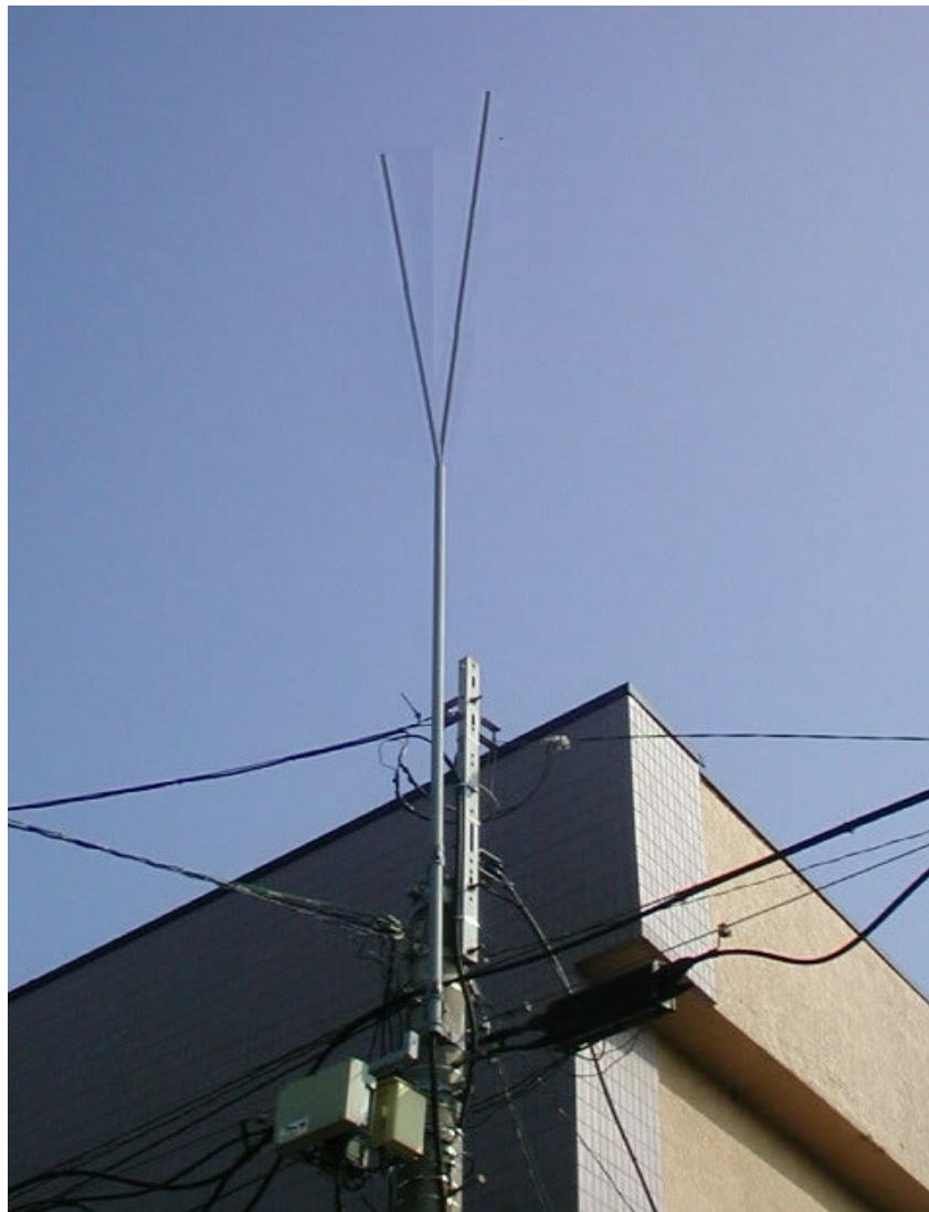
図3-15 V字形ダイバーシチアンテナ
