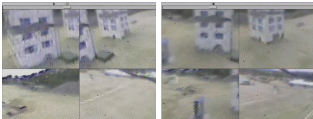
(a) 北側の被災したビル
